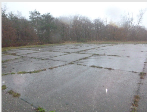
Aanzicht dilatatie voegen tussen betonnen platen.
