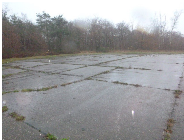
Aanzicht dilatatie voegen tussen betonnen platen.
